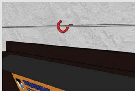
Colocar los ganchos de tornillo y colocar el cable de tracción
